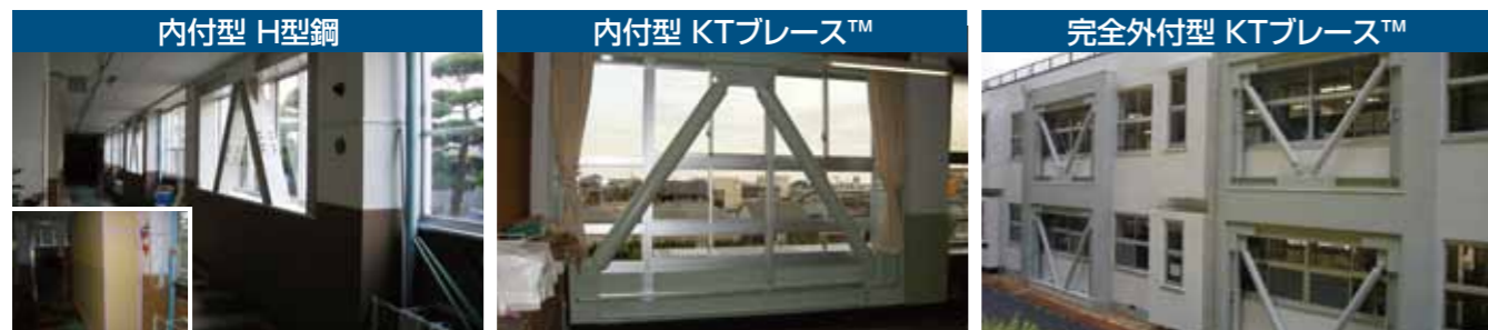
▲ 施工風景 (内部は使用しながら施工)
